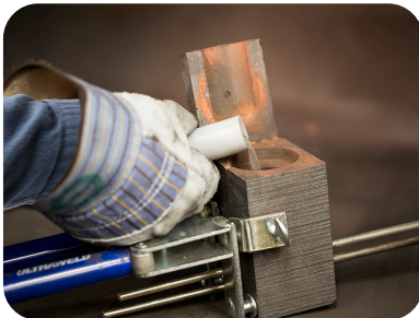
Step 4: Remove Clear cap from NuwTube, pour weld metal into mold.
